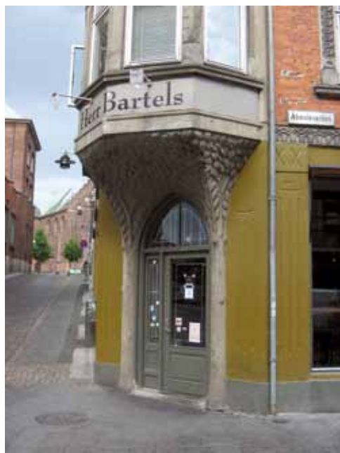
Den flotte indgangsportal hos "Herr Bartels" på hjørnet af Åboulevarden og Harald Schoubys Gade. Foto juni 2008 af forfatteren.
